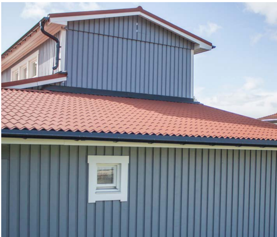
Plegeltaket på nära håll, där det syns hur profilerna liknar tegelpannor även om materialet är tunnare.
