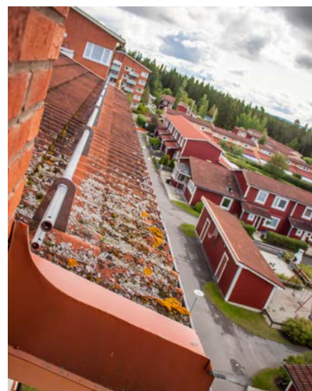
Tegeltak som varit nära exempelvis träd täcks snabbt av växtdelar, mossa och lavar, som i sin tur kan orsaka spräckta tegelpannor.
